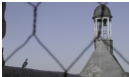
Grillage sur une église contre les pigeons.
