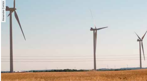
▲ Les éoliennes placées dans les grandes cultures sont généralement moins impactantes pour les chauves-souris.
