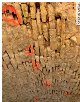
Conservation de disjointements favorables aux chauves-souris sous un pont (marquage avant travaux). ►
